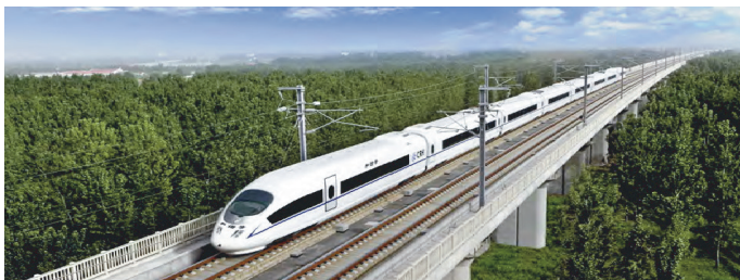
阿根廷高速轨道工程 High-speed rail project in Argentina
