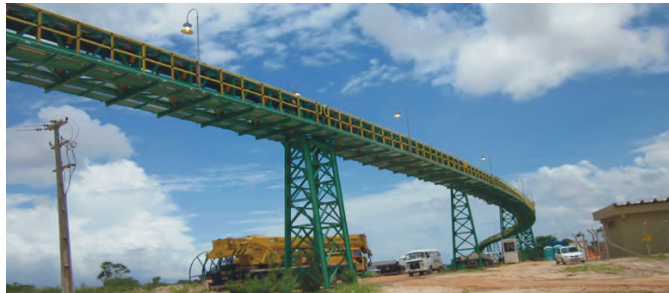
越南钢铁厂项目 Vietnam steel plant project
